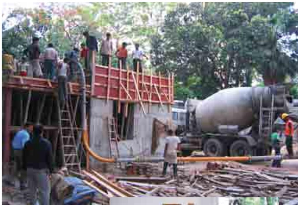
Decke betonieren, diesmal mit Betonpumpe
